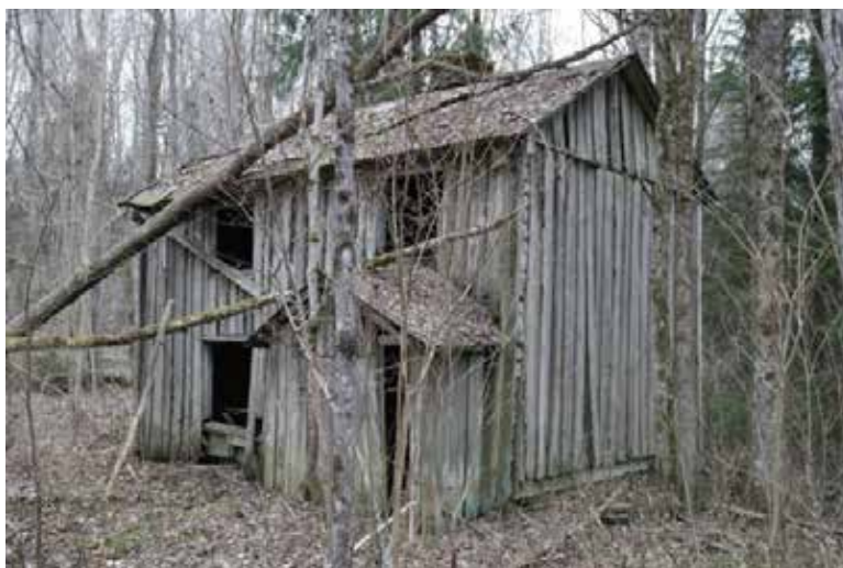
Bostadshuset på östra gården som idag är rivet. Foto: Örjan Hedman, november 2013.
