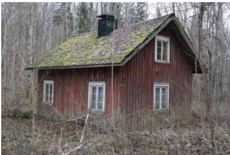
Bostadshuset på västra gården som idag är rivet. Foto: Örjan Hedman, november 2013.
